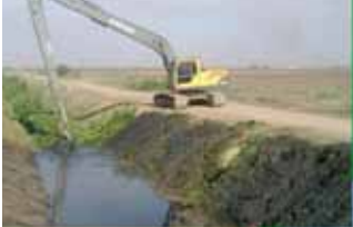
Conservación y limpieza de la red hidráulica.
