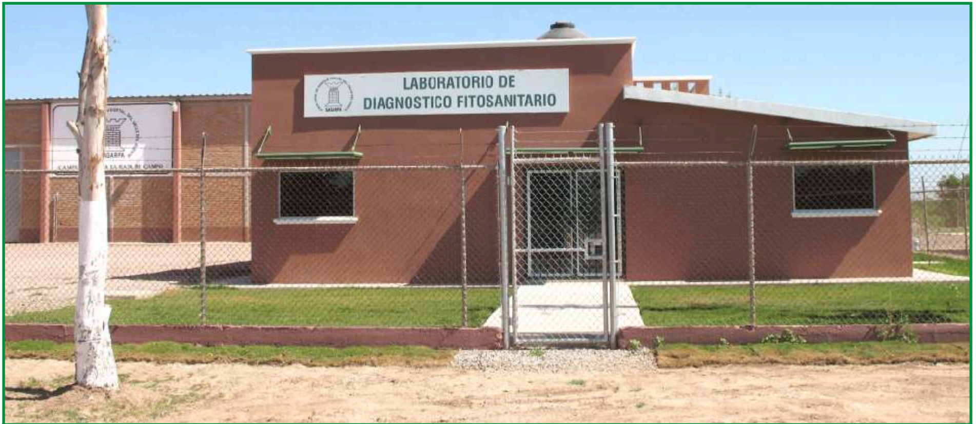
Fachada principal del Laboratorio de Diagnóstico Fitosanitario, ubicado por la carretera Los Mochis-Ahome en el km. 9, enseguida del Laboratorio de Insectos Benéficos de la Jlsvfvf.
